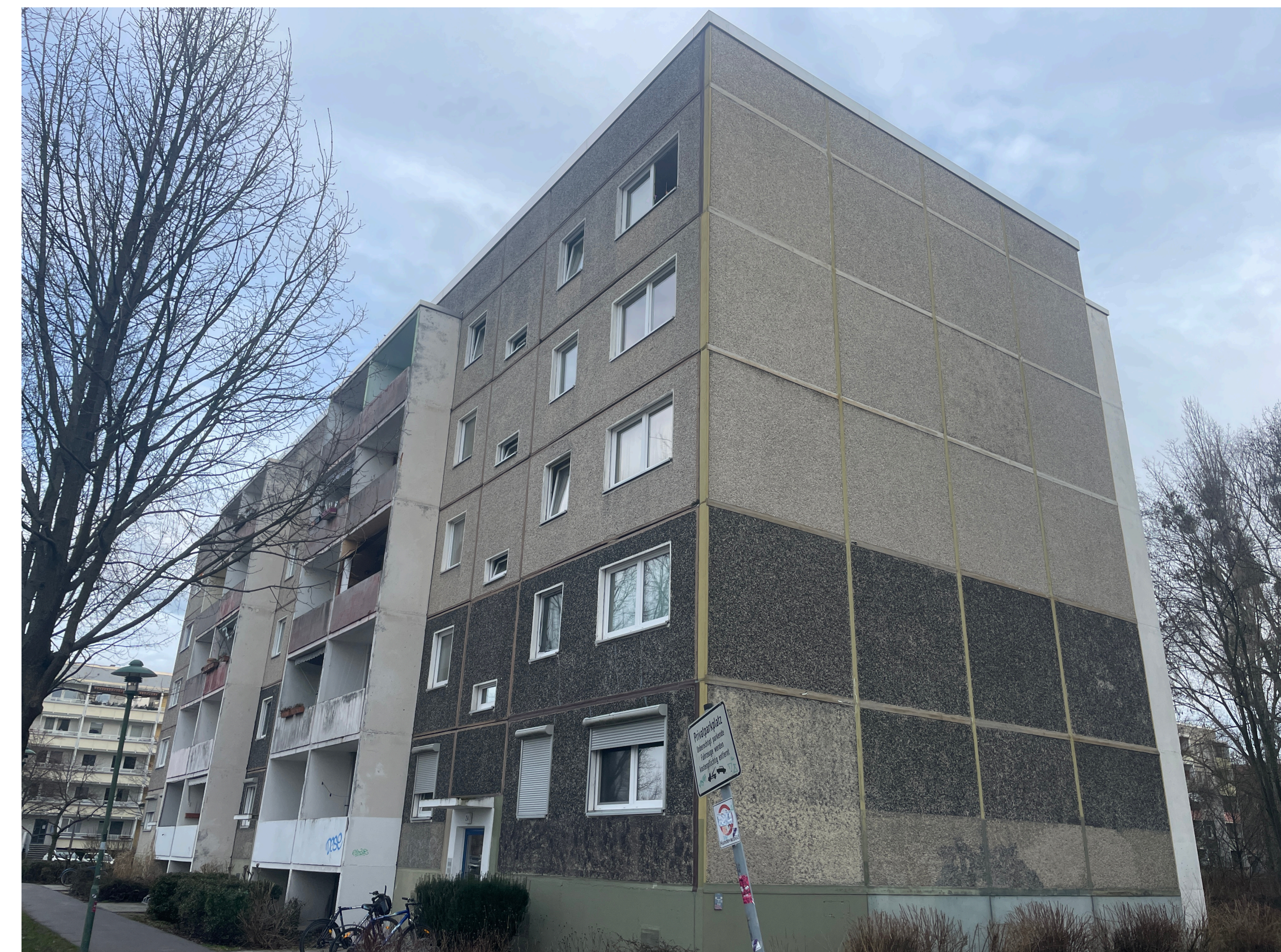
Abb. 2: Unsanierteres, fünfgeschossiges Mehrfamilienhaus der Wohnbauserie (WBS) 70 im Potsdamer Stadtteil Schlatz
